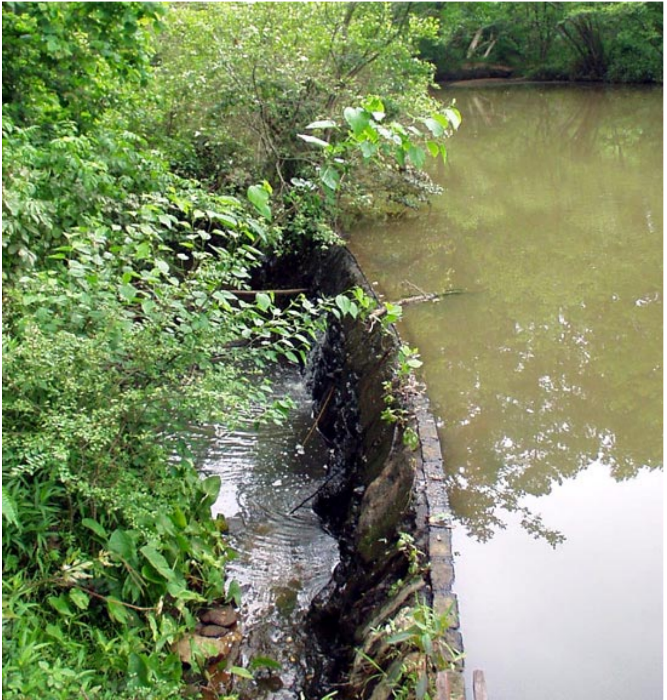
Figure 2 Candler Lake Dam.
